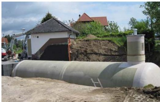
Eines der größten Projekte der letzten Jahre war die **Erweiterung des Wasserhochbehälters** mit Baubeginn im Frühjahr 2013. Zum bestehenden Behälter wurde ein Rohrbehälter mit einem Ausmaß von 54 m<sup>3</sup> samt
